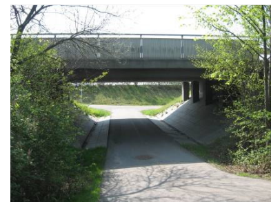
Gångtunnel till busshållplats (Bergström & Ekelund, 2007)
